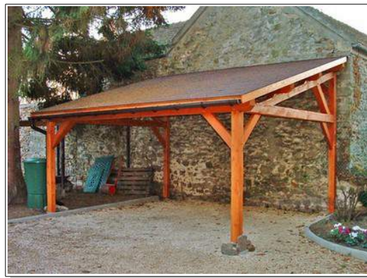
Abri de protection accolé à bâtiment (adjonction)
