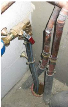
Exemple d'entrées de réseaux à calfeutrer
