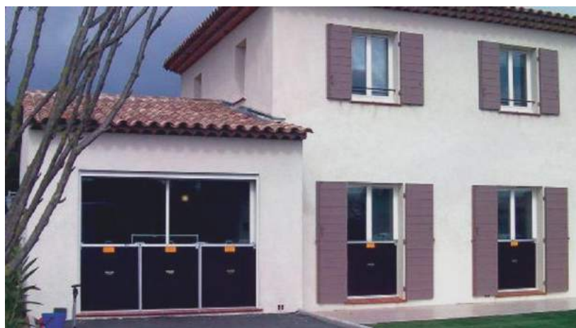
Exemple de protections des ouvertures
