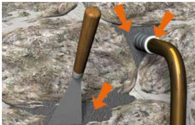
Situation après travaux de colmatage
